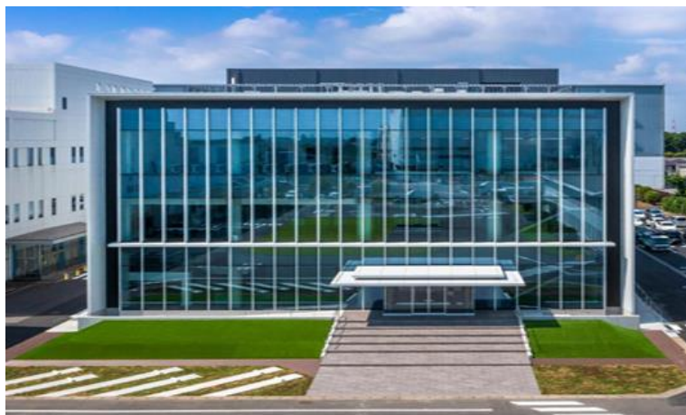
ニプロファーマ埼玉試験棟 (2023年12月稼働)
