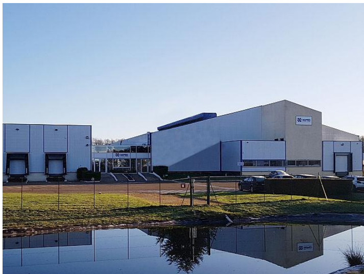
[オートン工場（フランス）]
