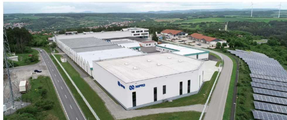
シリンジ製造棟の全景
