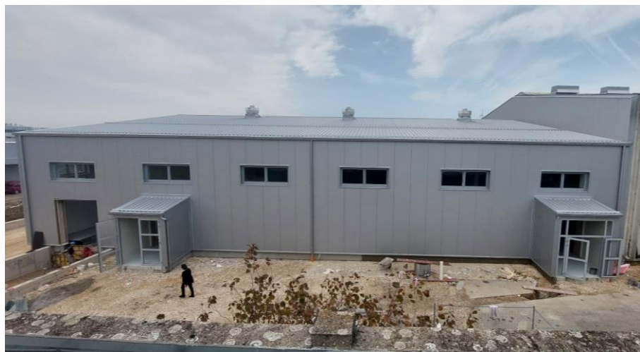
新工場の建設状況（2022年10月）
