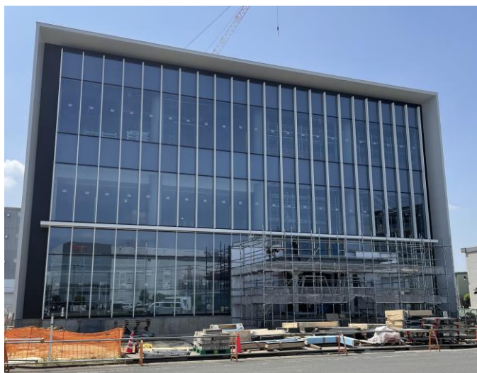
埼玉QC棟 2023年6月稼働 ※QCトレーニングセンターを併設
