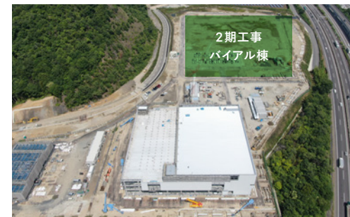
建設中のニプロファーマ近江工場
