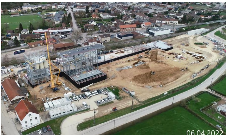
新工場の建設状況（2022年4月）
